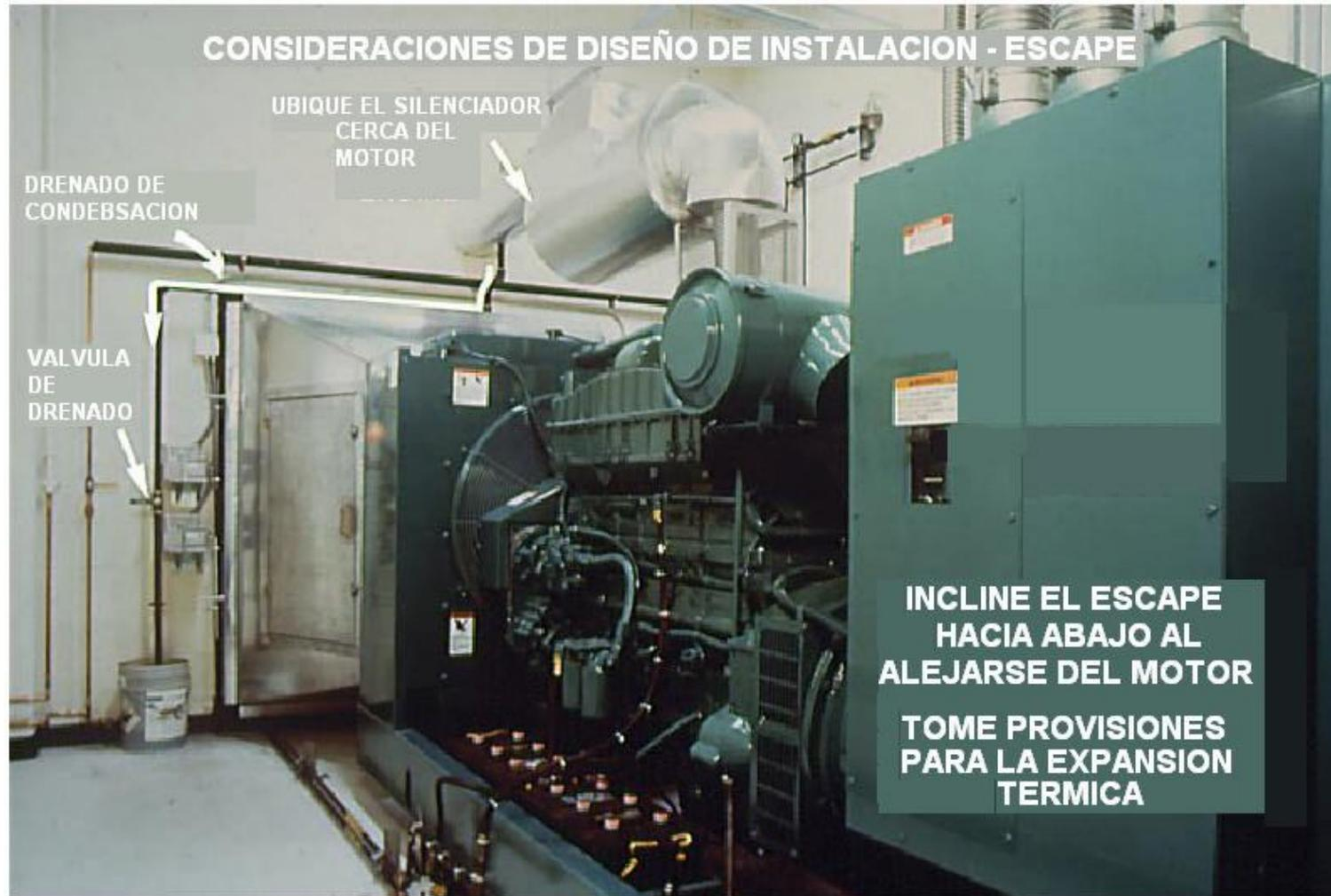
Figura 6-5: Características Típicas de un Sistema de Escape para un Generador Instalado Dentro de un Edificio
