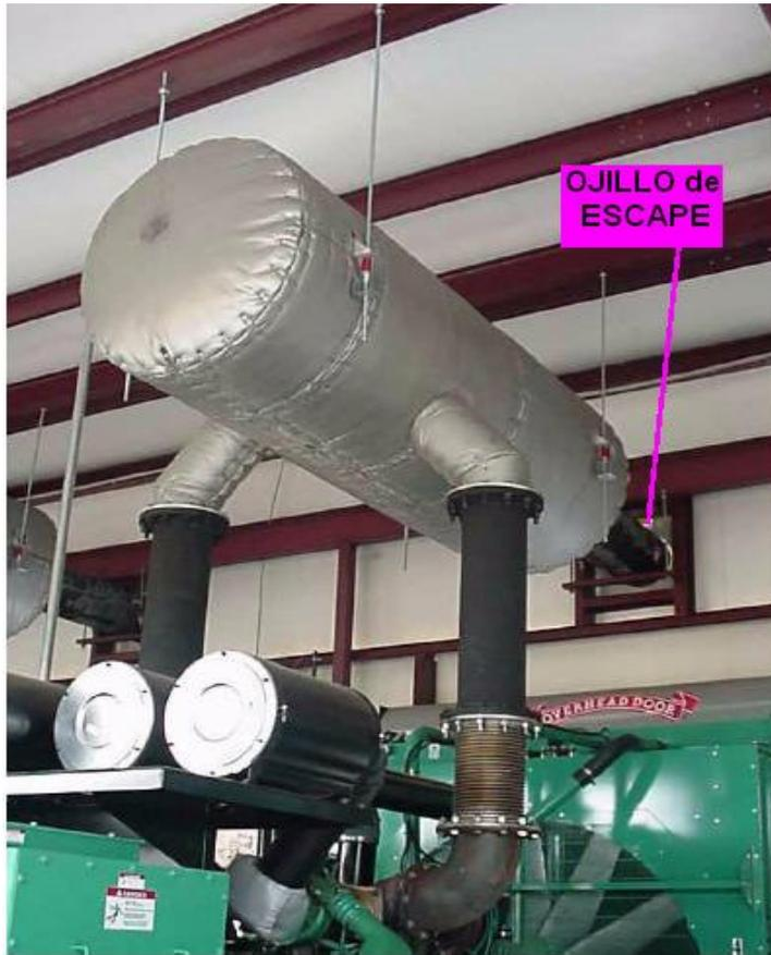
**Figura 6-7:** Características del Escape del Generador Silenciador de Doble Entrada, Conectores Flexibles, Se muestran los Ojillos de Escape, y los Montantes Colgantes
