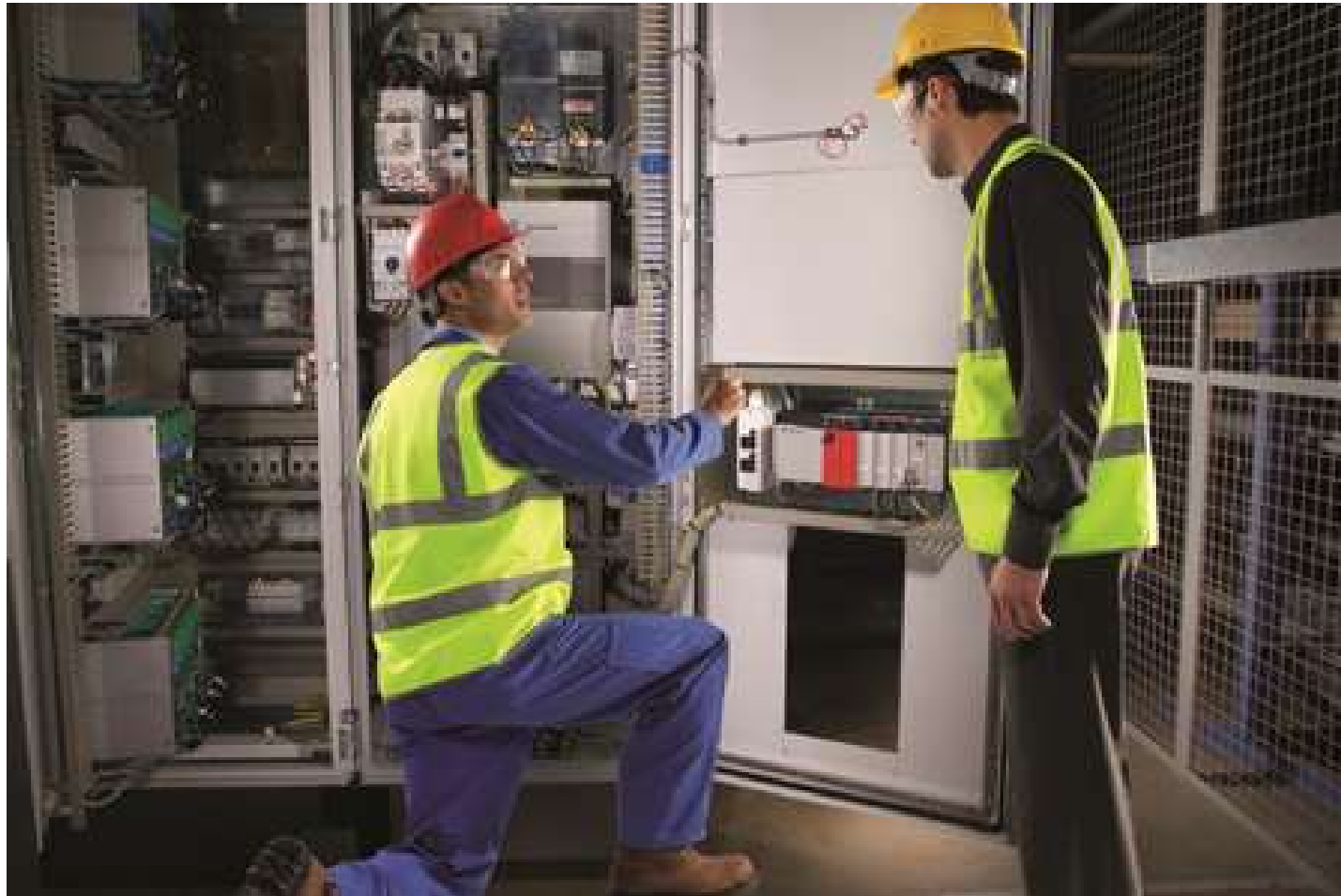
MANTENIMIENTO DE VARIADORES DE VELOCIDAD
