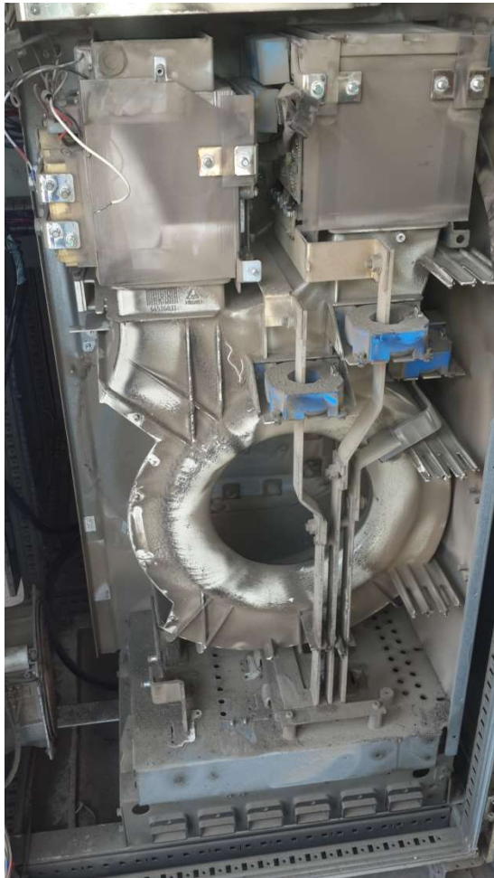
MANTENIMIENTO DE VARIADORES DE VELOCIDAD
